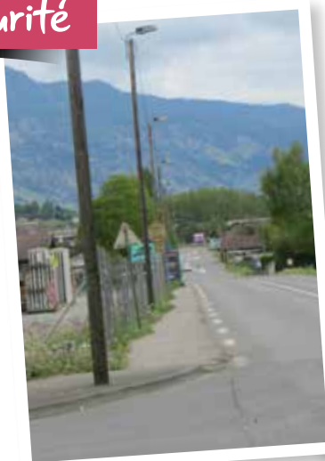
Avenue des Voirons
