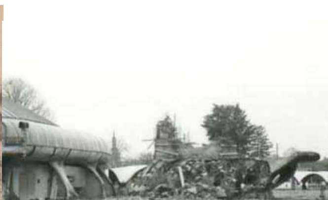
Après passage du bulldozer, 1977 Archives commission du patrimoine de Douvaine
