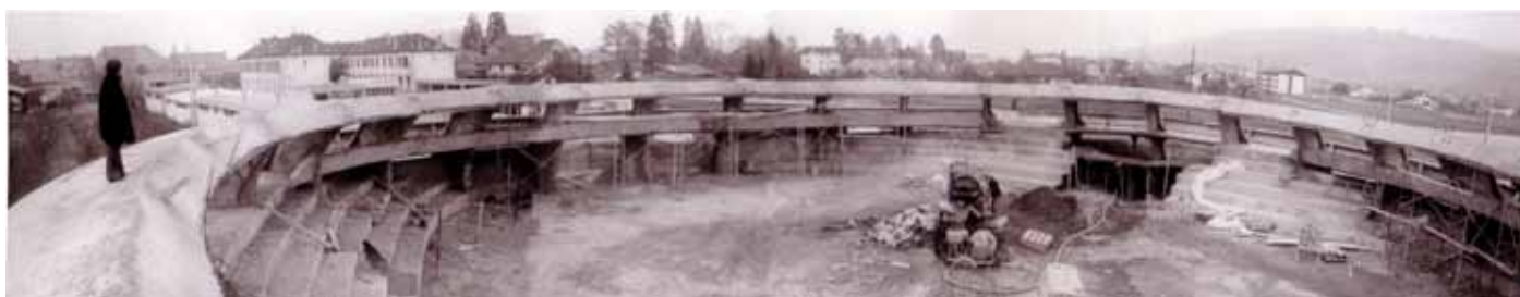
Pascal Häusermann sur le chantier de la «Bulle», 1973, archives Commission du patrimoine de Douvaine.
