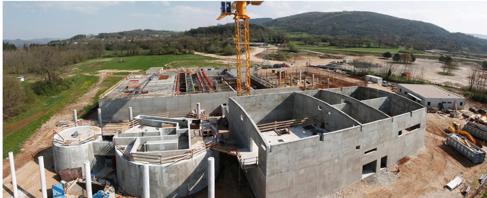
Image d'un chantier de MAURO
